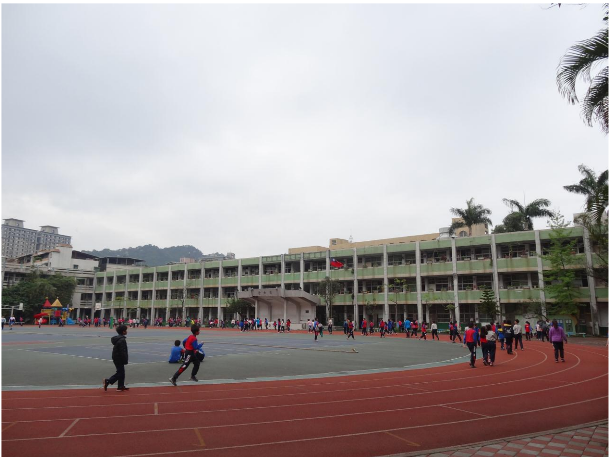
仁愛樓整棟熄燈狀況
