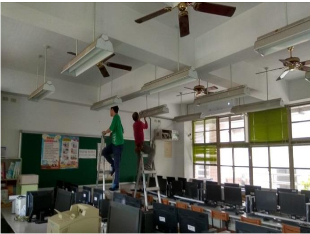
節能廠商開始到校施工--電腦教室
